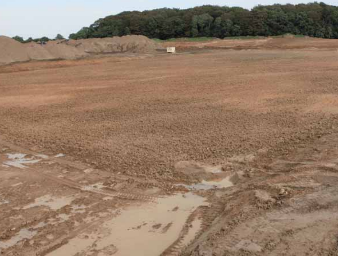
Det er mindst lige så vigtigt at råjorden ligger i en naturlig lejring som at lægge rødræn. Her er råjorden æltet sammen under våde forhold.
